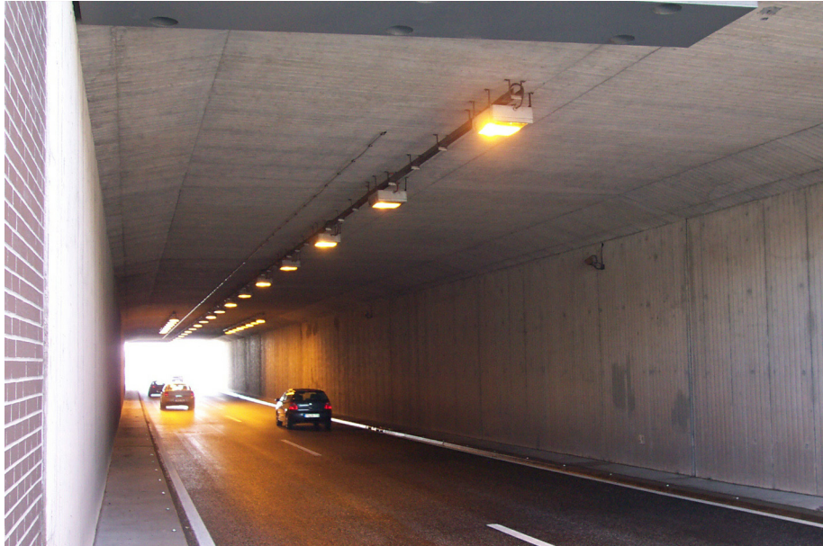
1 Blick in den Straßentunnel bei Wolmirstedt
